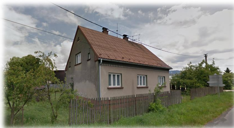
Obrázek 9 Brownfield - dům ve špatném technickém stavu v obci Nižní Lhoty
