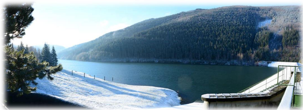
Obrázek 21 Snaha o zprůchodnění vodního díla Morávka
