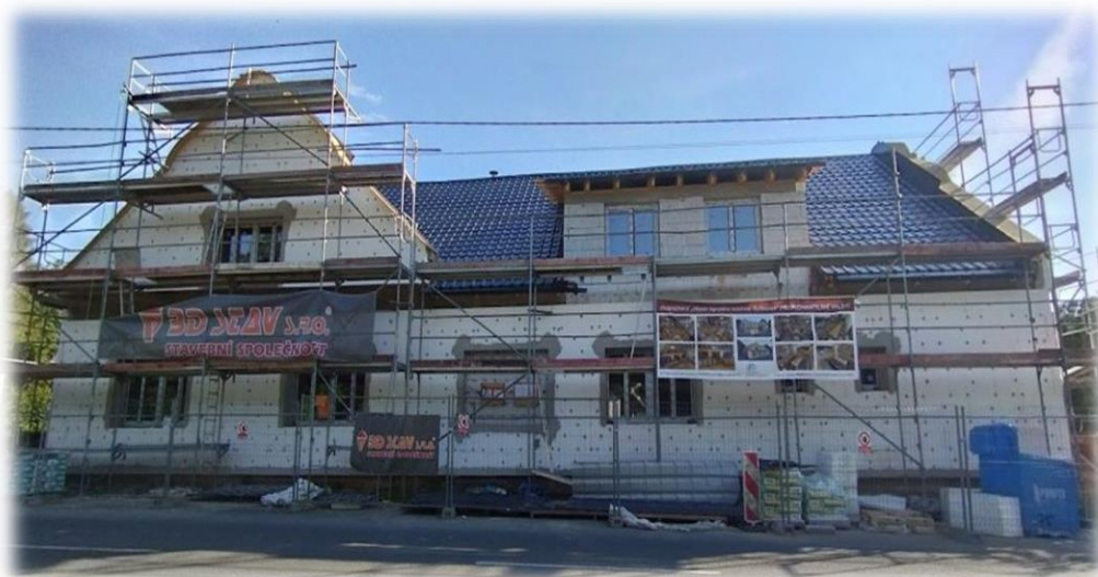
Obrázek 12 Probíhající rekonstrukce kulturního a komunitního centra v obci Raškovice
