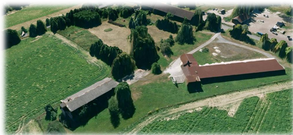
Obrázek 7 Budova bývalého JZD v obci Řepiště (vlevo)
