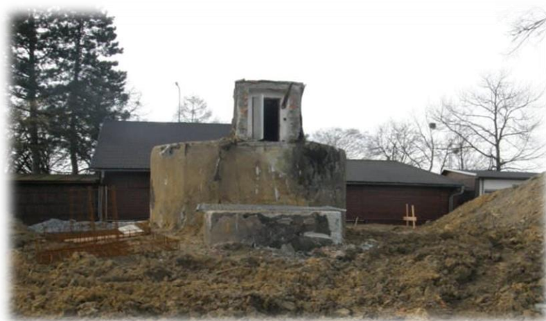
Obrázek 14 Příprava stavby Rozhledny na Bezručově vyhlídce v Sedlištích
