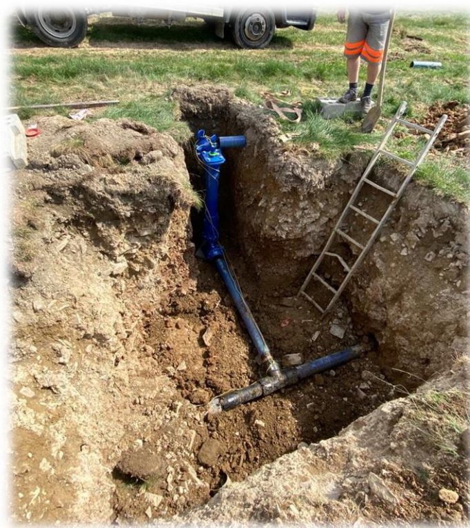
Obrázek 15 Stavba vodovodu v obci Vyšní Lhoty
