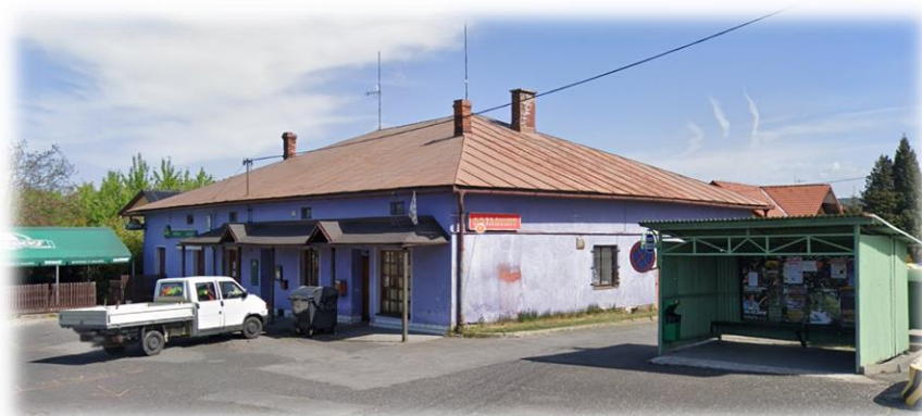
Obrázek 18 Budova hostince s bývalým obchodem potravin v obci Kaňovice
